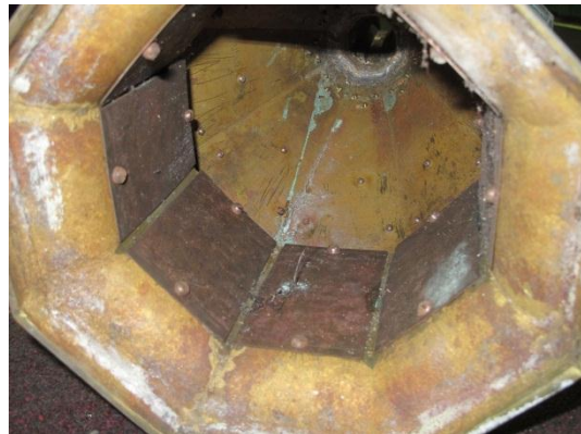
Figuur 7: Binnenzijde toren
