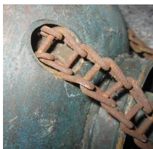
Groene niet egale corrosie
